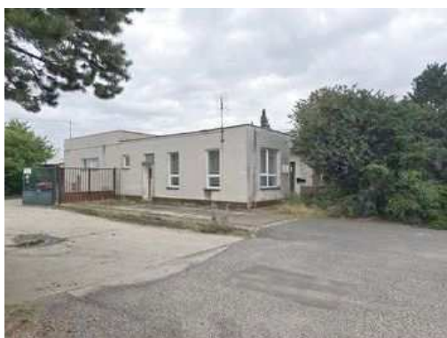
adm. budova čp. 116
