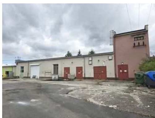
provozní budova, trafostanice
