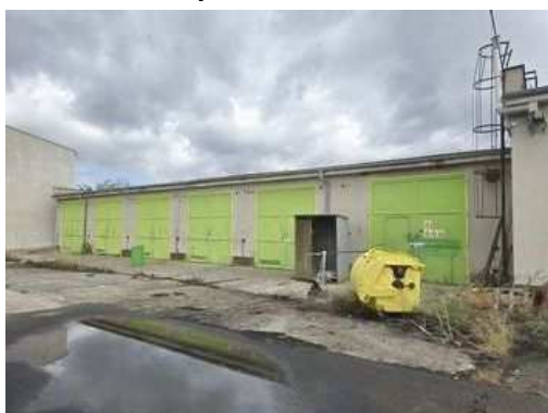
provozní budova - garáže s dílnou
