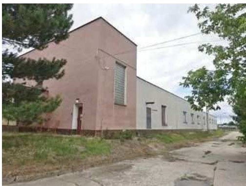
TS a provozní budova
