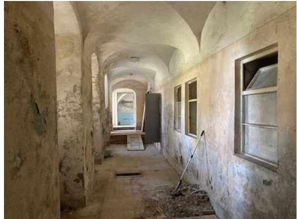
zámecká budova - chodba
