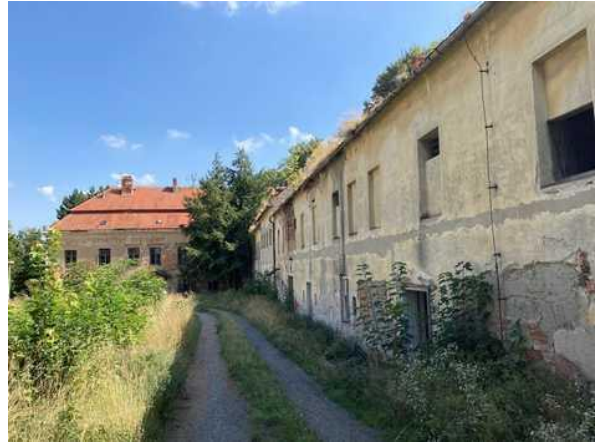
hospodářské křídlo - pohled ze SZ
