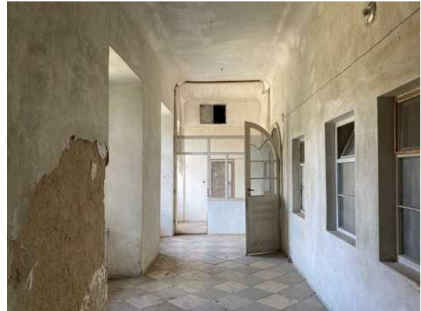
zámecká budova - chodba
