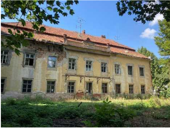
zámecká budova č.p. 1 pohled z V
