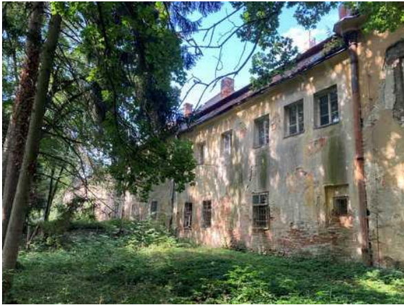
hospodářské křídlo - pohled z JV
