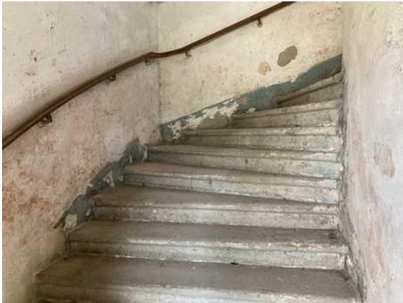
zámecká budova - schodiště
