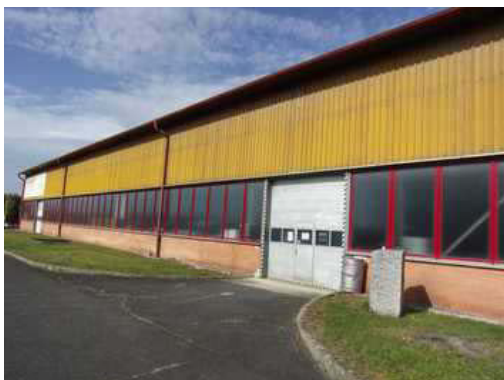
Hala - boční pohled
