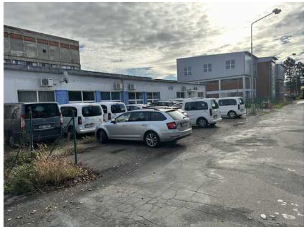
parkovací stání před hlavním vstupem do objektu
