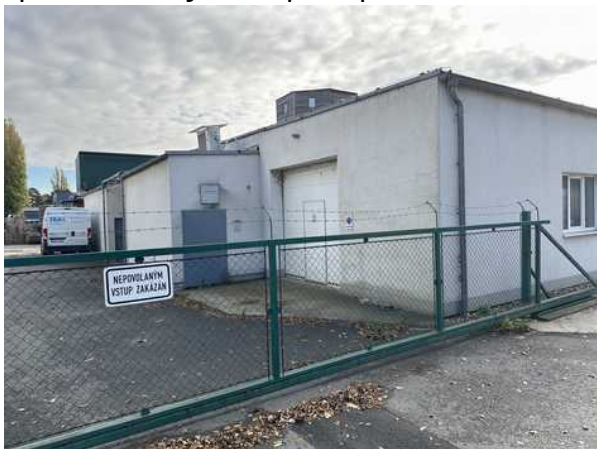
pohled na boční stěnu s provedenými přístavky
