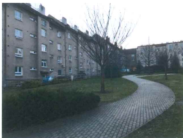
Pohled z vnitrobloku
