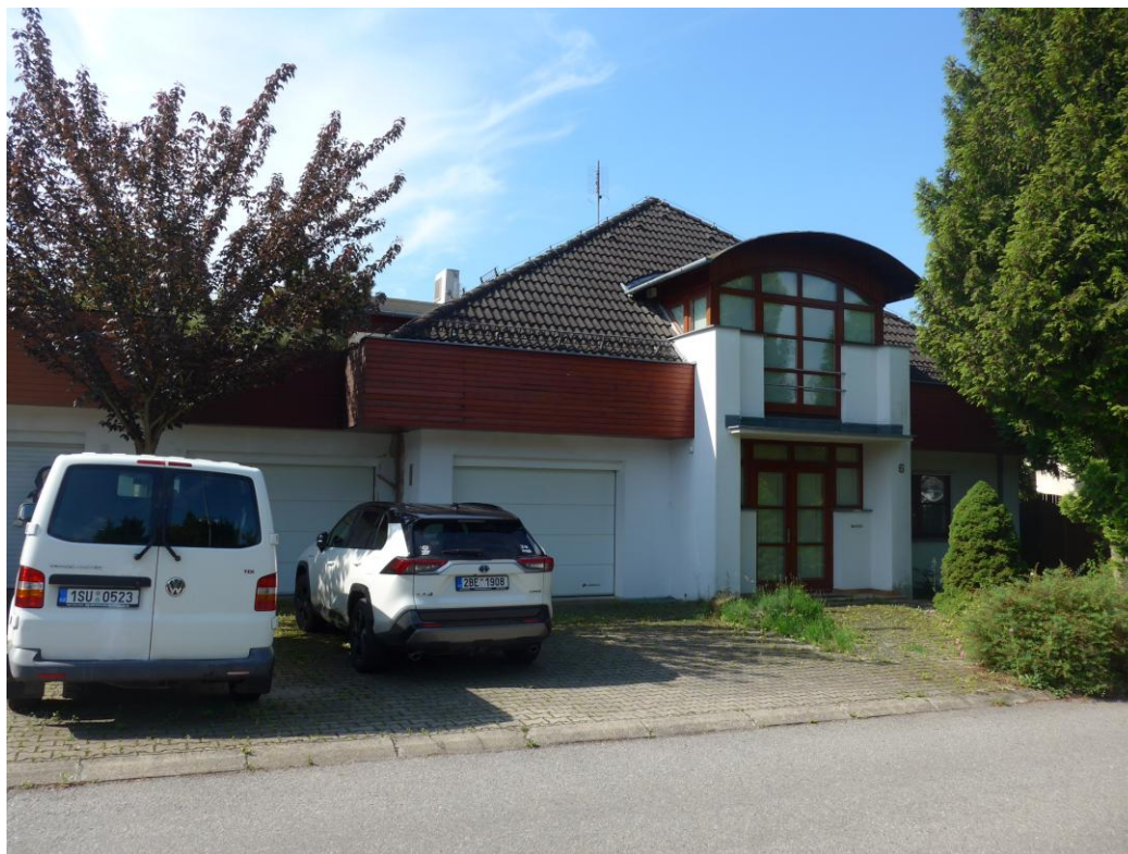
foto č. 1 - pohled levý přední na rodinný dům z ulice Havláškovy
