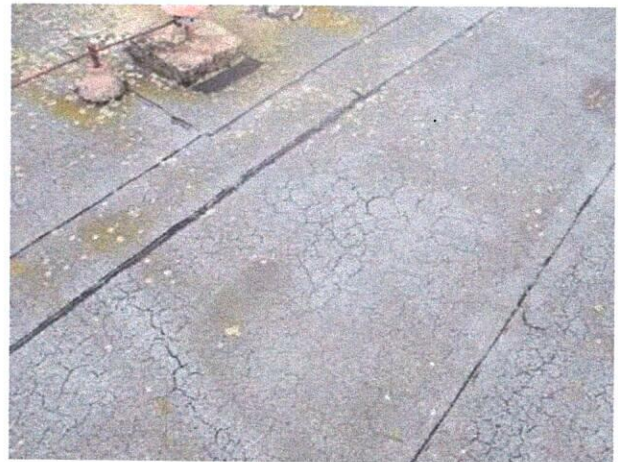
Popraskání povlakové krytiny
