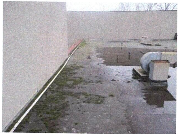
Popraskání povlakové krytiny
